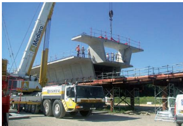
Figure 10 : Pose à la grue de la première travée sur cintre - Source : VINCI
