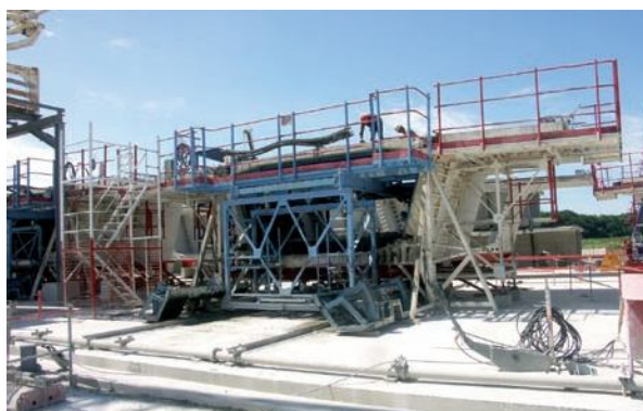
Figure 7 : Cellules de préfabrication des voussoirs - Source : VINCI
