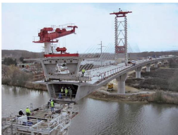
Figure 16b : Pose des voussoirs à l'avancement par haubanage provisoire - Source : VINCI
