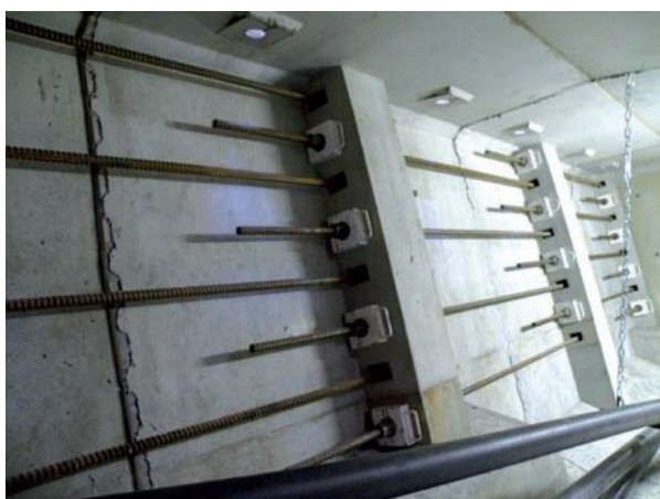
Figure 14 : Brèlage provisoire des voussoirs - Source : CETE
