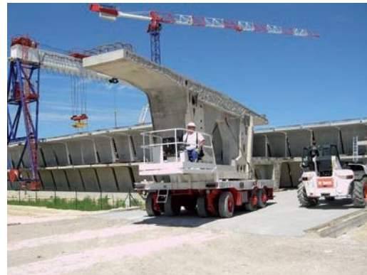
Figure 12 Fardier de transport des voussoirs - Source : VINCI
