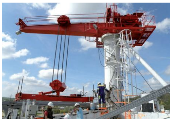
Figure 9 : Potence de pose des voussoirs - Source : VINCI
