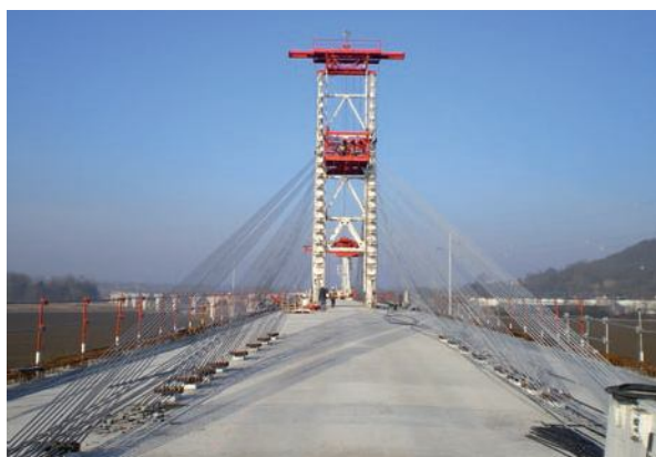
Figure 8 : Haubannage du tablier - Source : CETE
