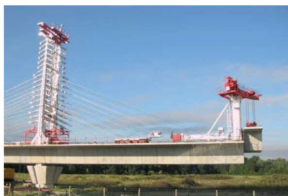
Figure 15 : Mise en place d'un voussoir - Source : VINCI
