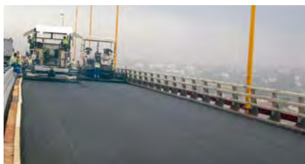
Photo 7 : mise en œuvre du CER – Source : CETE de l'Ouest
