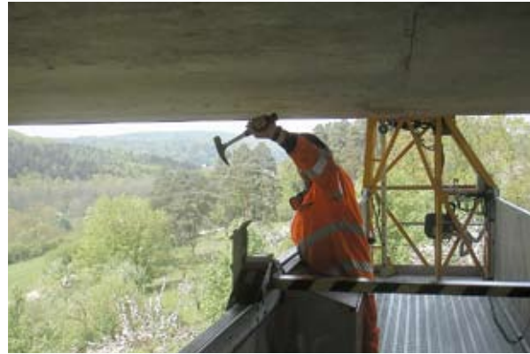
Photo 2 : les outils les plus importants de l'inspecteur de ponts allemand sont le marteau... et l'oreille.
