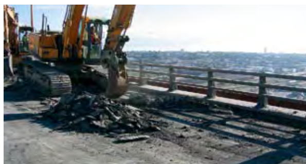
Photo 5 : décapage du complexe existant – Source : CETE de l'Ouest
