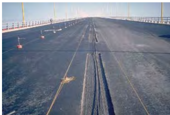
Photo 2 : réalisation du CER en 1991 - vue du rabotage partiel pour encastrer la DBA - Source : Cindoc, Sétra
