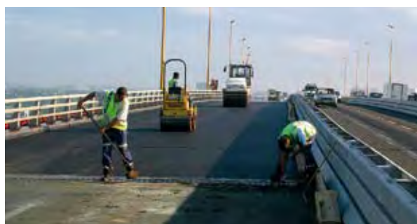
Photo 9 : finition – Source : CETE de l'Ouest
