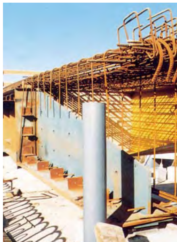
Photo 3 : pièces de pont d'about de caisson mixte avant mise en place de tous les aciers et bétonnage
