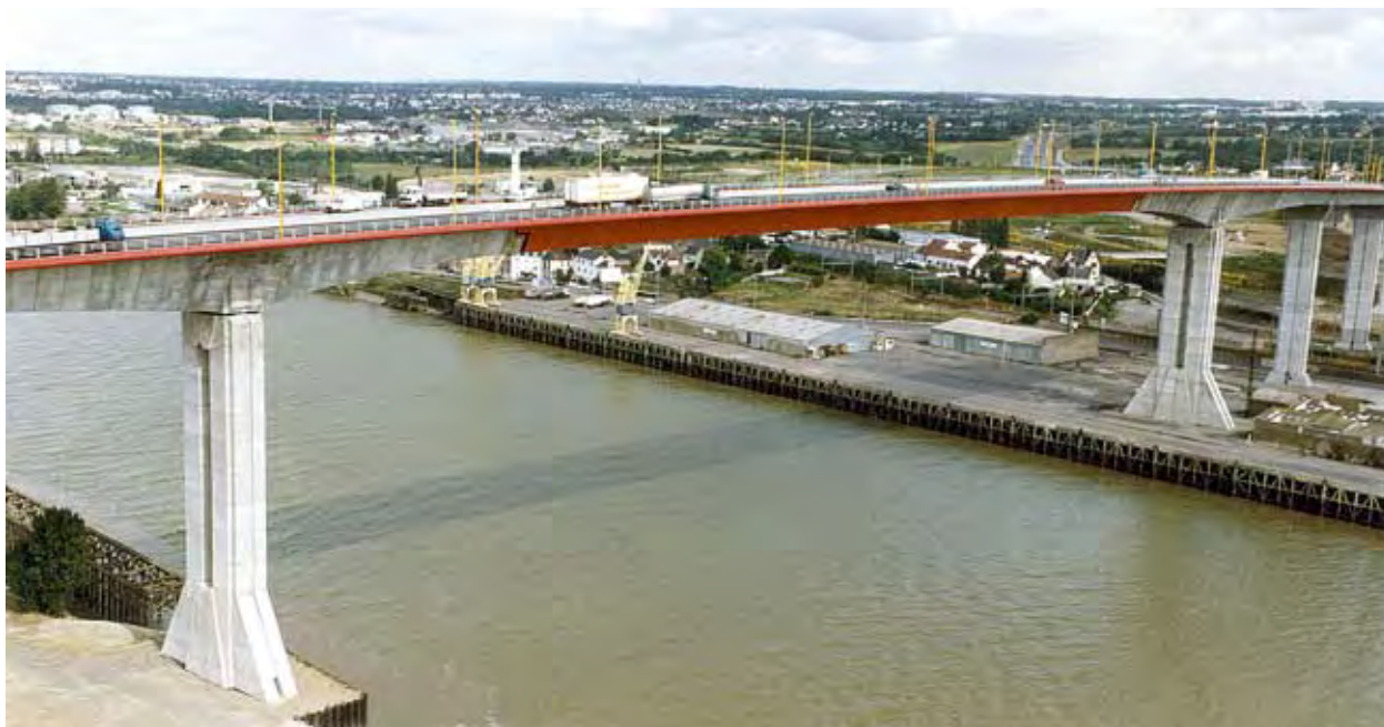
Photo 1 : pont de Cheviré - travée métallique – Source : Gérard Forquet, Sétra
