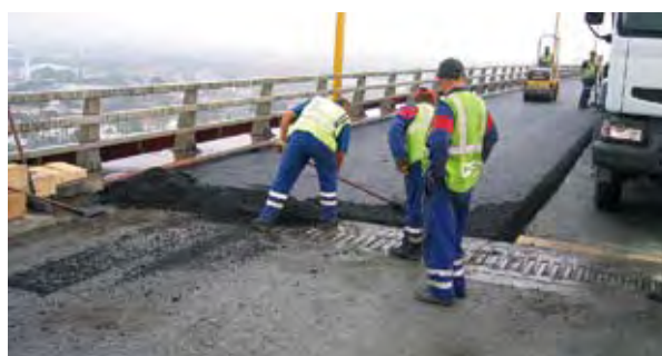
Photo 8 : traitement du joint de chaussée – Source : CETE de l'Ouest
