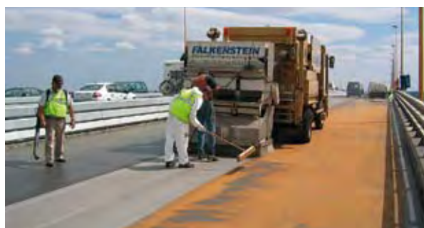
Photo 6 : application du vernis de protection – Source : CETE de l'Ouest
