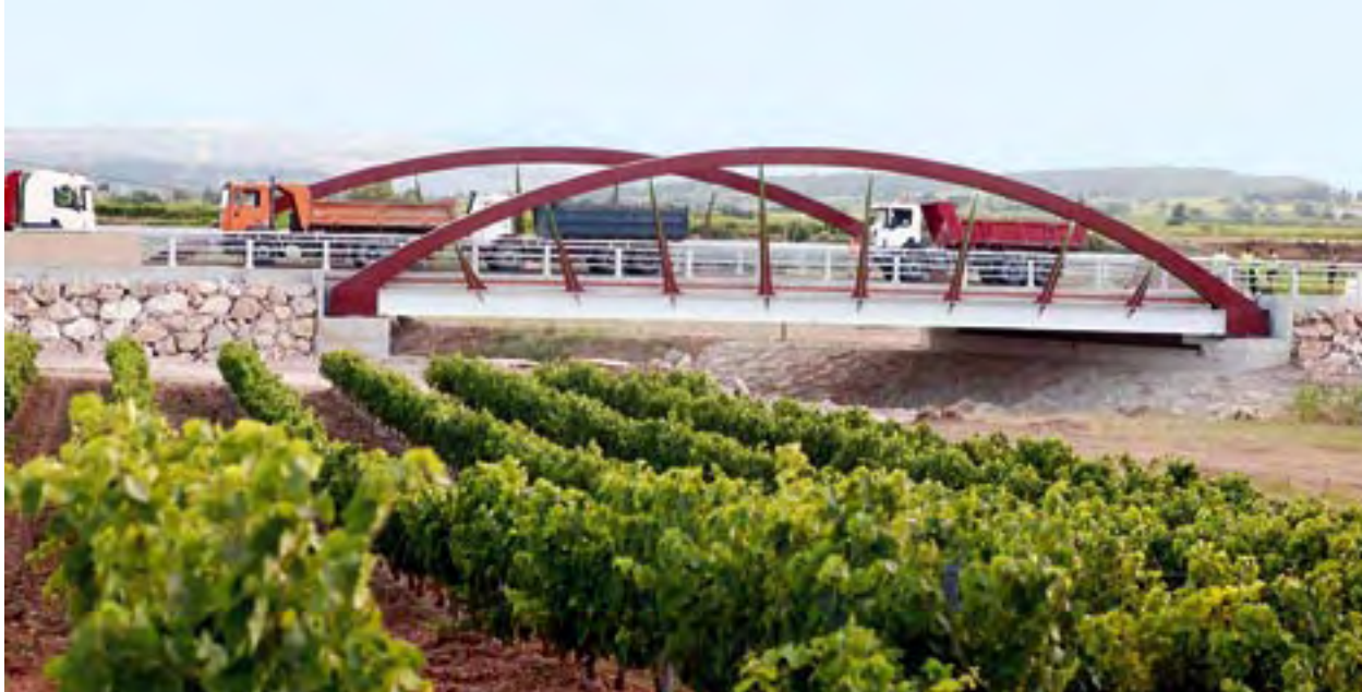
Photo 16 : vue du pont depuis la vigne voisine – Source : Gérard Forquet (Sétra)
