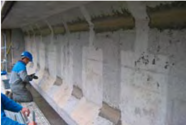
Photos 4 et 5 : préparation (reprofilage + meulage) – Source : Freyssinet
