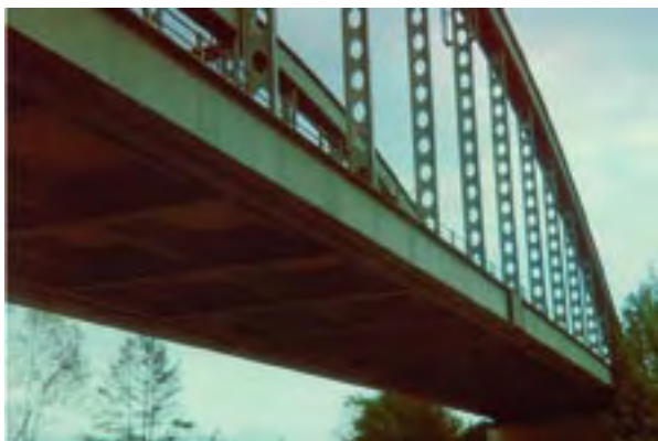
Photo 2 : franchissement de la Marne – Source : Jacques Berthelémy (Sétra)
