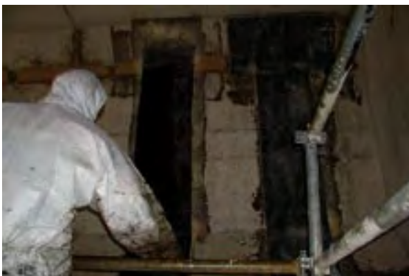
Photo 6 et 7 : pose du TFC en cours + poutre terminée – Source : Freyssinet
