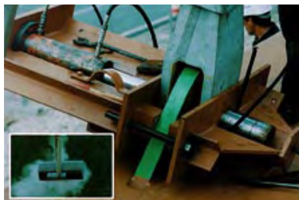
Photo 6 : mise en place d'un axe définitif dans une douille à chapes en pied – Source : Jacques Berthelémy (Sétra)
