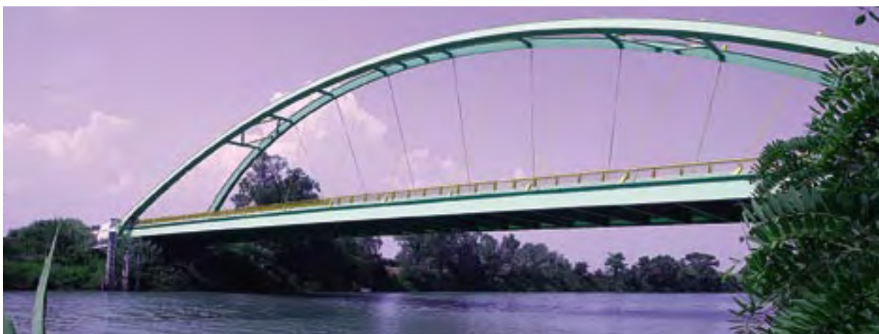
Photo 4 : pont de Saint-Gilles - Les suspentes en câbles clos sont peu perceptibles visuellement – Source : Gérard Forquet (Sétra)
