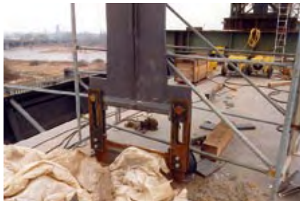
Photo 7 : pied d'une suspenste du pont de Wittenberg Source : Jacques Berthelémy (Sétra)
