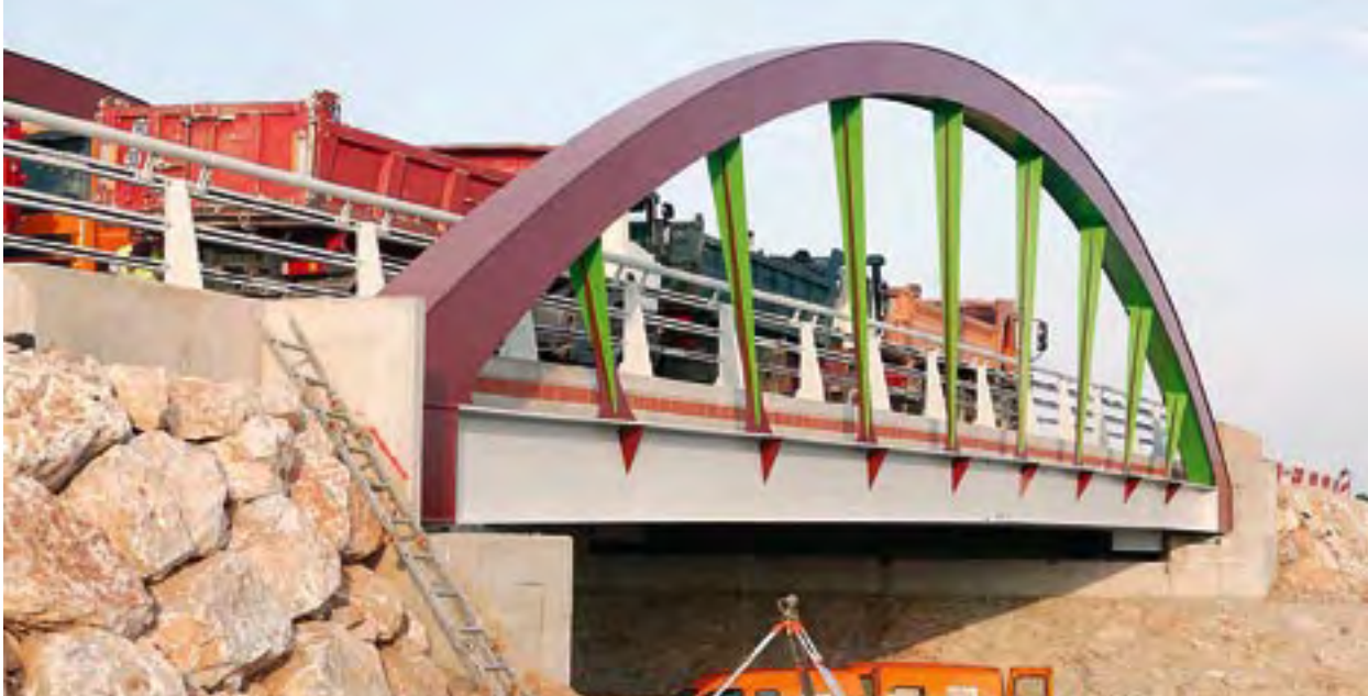
Photo 15 : épreuve de l'ouvrage – Source : Gérard Forquet (Sétra)
