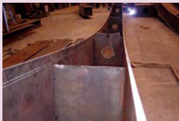
Photo 8 : points supérieurs d'attache des suspentes Source : Jacques Berthelémy (Sétra)
