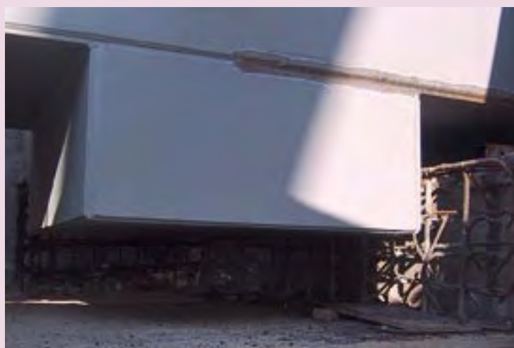
Photo 10 : ferrailage de la culée au droit de la butée anti-sismique Source : Jacques Berthelémy (Sétra)
