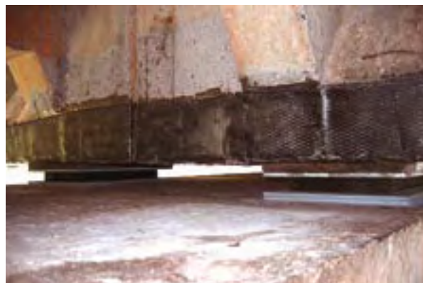
Photo 2 : renforcement appuis – Source : Freyssinet
