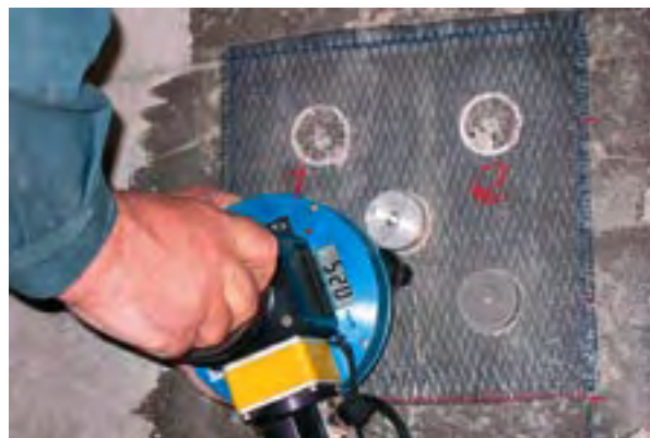
Photo 3 : essai d'arrachement – Source : Freyssinet
