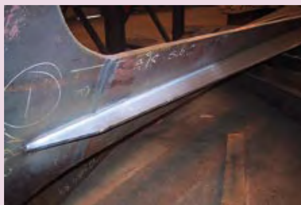
Photo 9 : partie basse d'une suspenste – Source : Jacques Berthelémy (Sétra)
