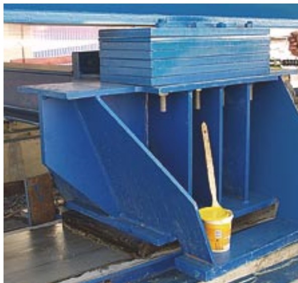
Appui provisoire glissant sur longrine de lançage
