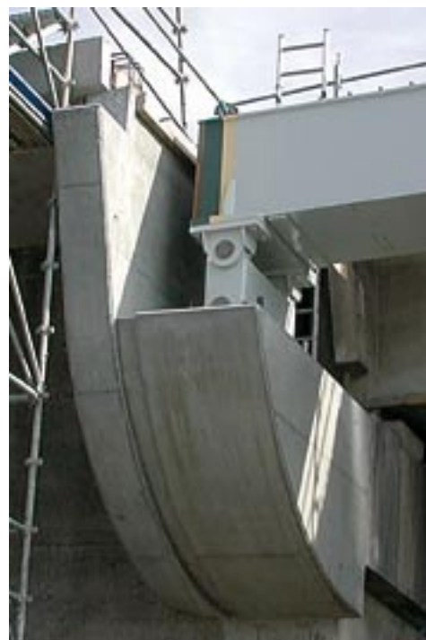
Figure 6 : console d'appui en CO, au droit de la culée et au droit du VIIP et l'appareil d'appui
