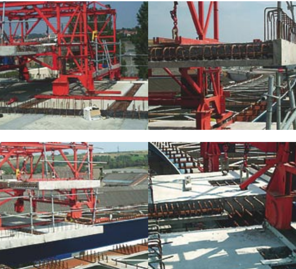
Dalle préfabriquée en cours de pose avec chariot
