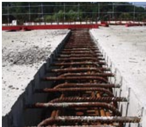
Zones de clavage (ferrailage en cours) et fenêtres de connexion
