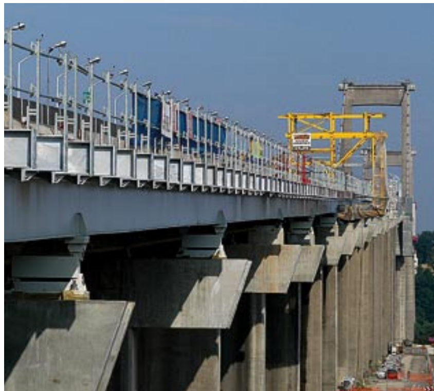
Figure 9 : vue générale de l'ouvrage d'élargissement avant pose des écrans
