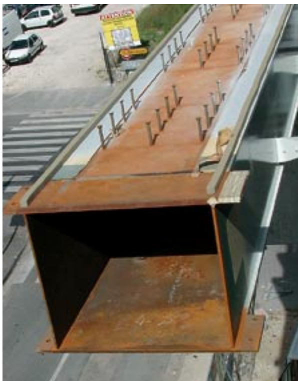
Figure 7 : caisson métallique en cours de pose
