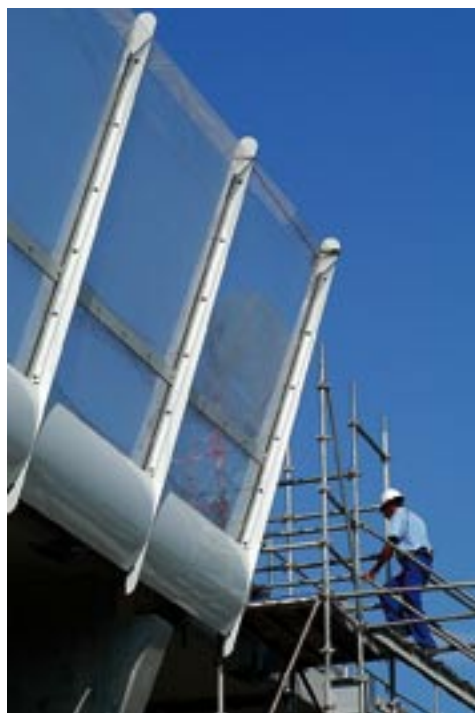
Figure 5 : équipements des ouvrages d'élargissement (prototype et pose des écrans)
