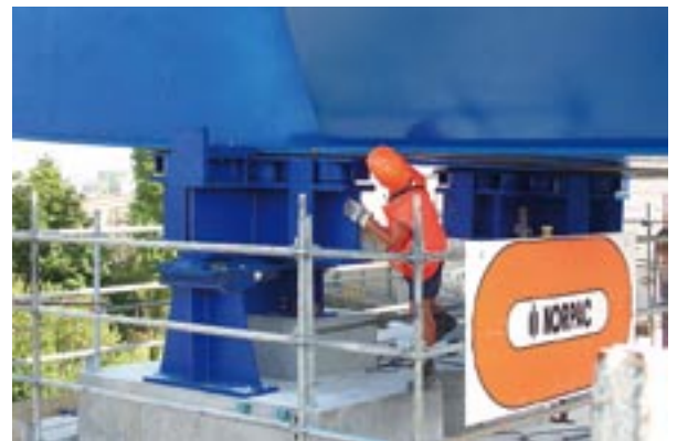
Balancoire et guidage latéral sur pile
