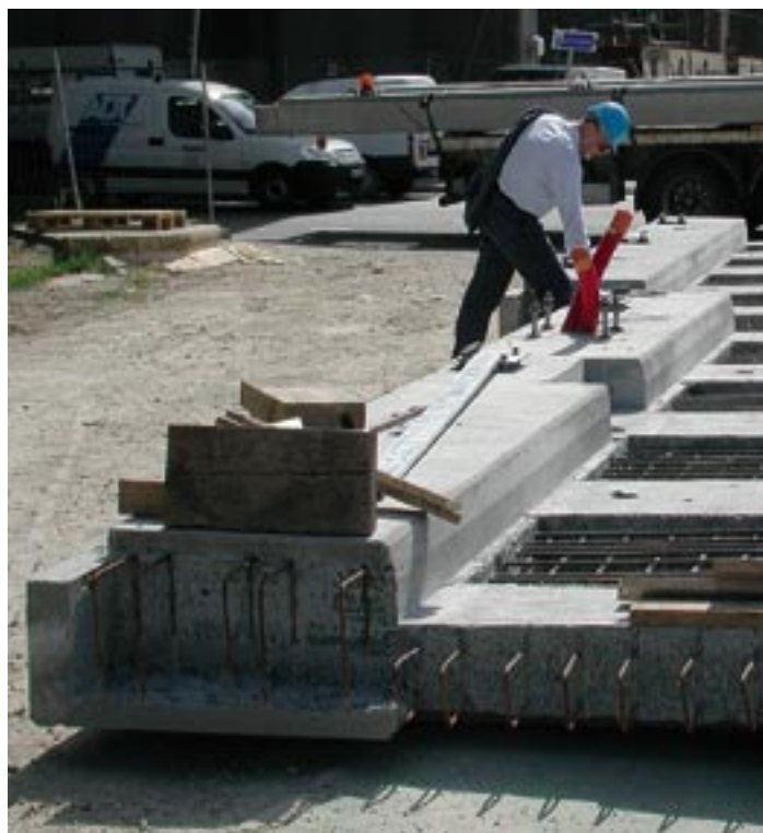
Figure 8 : dalles préfabriquées du hourdis
