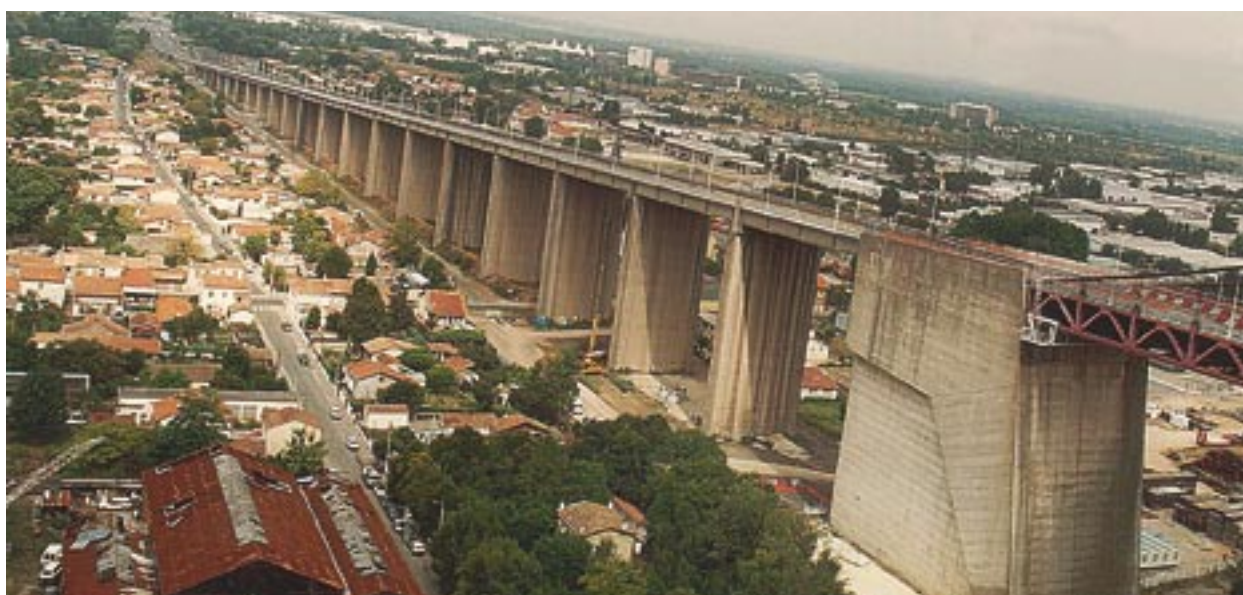
Figure 1 : vue de l'ouvrage avant travaux
