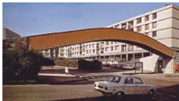
Photo 7 : passerelle Cocteau construite à Nîmes. Arc lamellé-collé sans protection vis-à-vis des chocs et de la pluie (1975)
