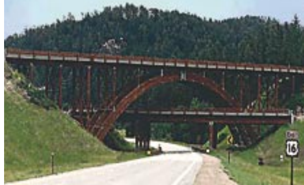
Photo 6 : pont de Keystone-Wye dans le Sud-Dakota Arc lamellé-collé à l'abri sous une dalle (1968)
