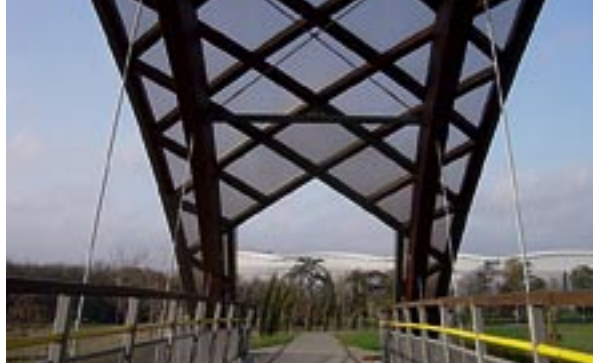
Photo 10 : vue intérieure de la passerelle Pinot, de 36m de portée. Les arcs sont en bois, les tirants et suspentes en acier et la dalle en béton
