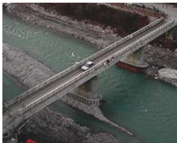
Photo 1a : pont du Brouchier
