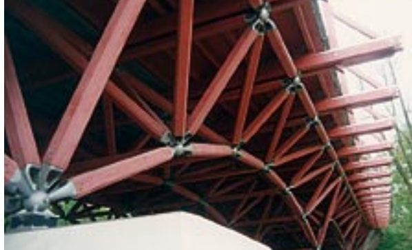
Photo 8 : pont de Thalkirchen
