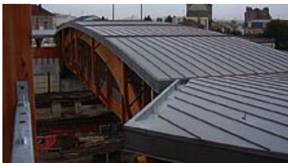
Photo 11 : passerelle de Vayres sur Marne bien abritée sous sa toiture
