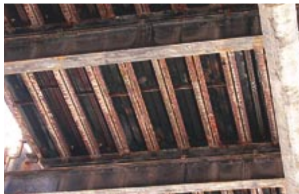
Photo 1b : état de la structure métallique
