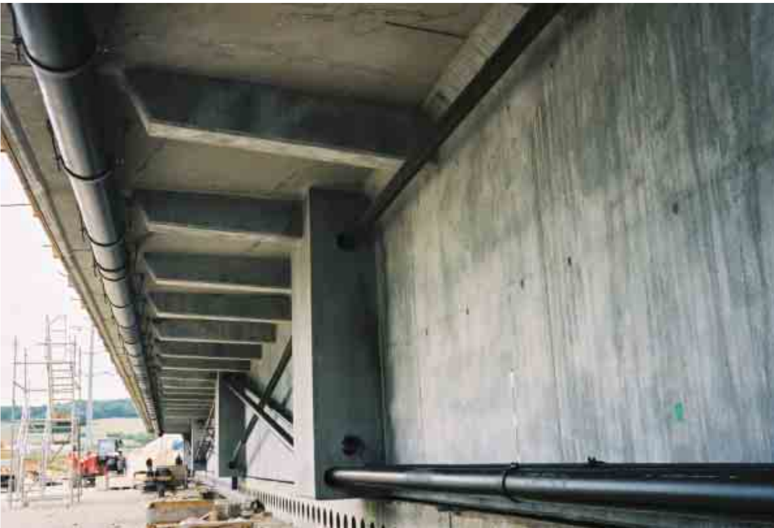
Vue du tablier avant poussage Au premier plan : déviateur de la travée centrale
