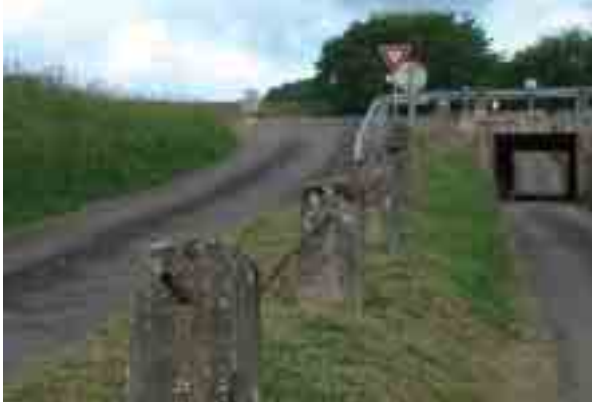
Figure 1 : élévation (vue du PI et chemin d'accès avec la RN6)
