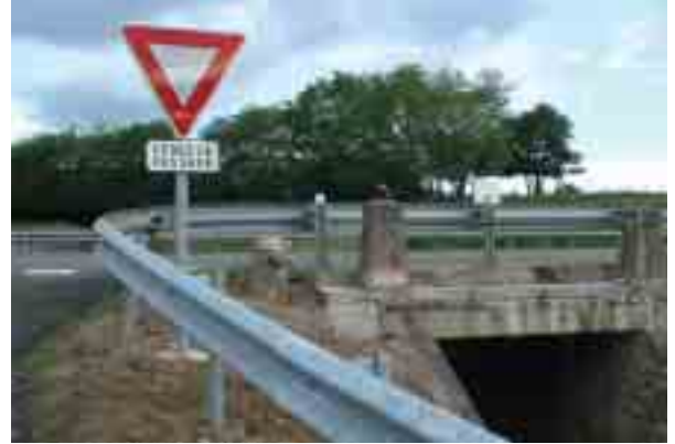
Figure 2 : vue de détail de l'aménagement actuel
