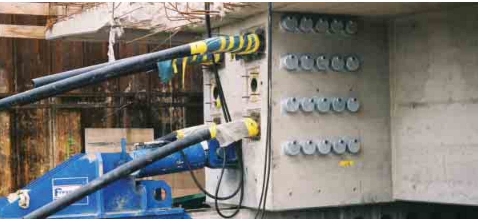
Ancrage des câbles sur culées
