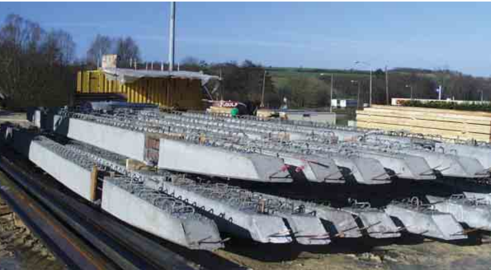
Préfabrication des nervures transversales
