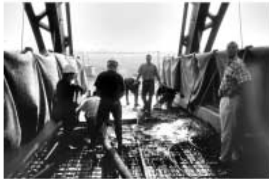
◀ Bétonnage du hourdis.
