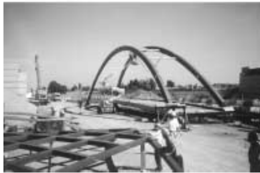
◀◀ Montage à blanc dans l'usine Matière.
