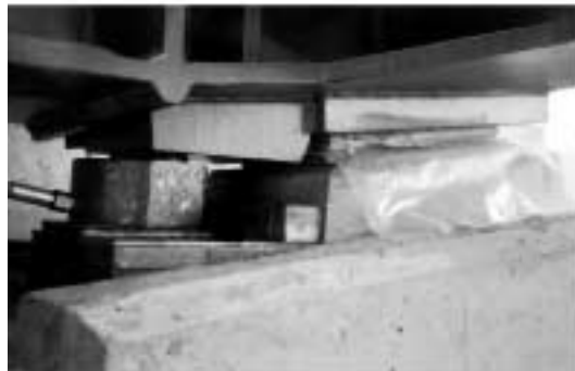
◀ Vérinage de mise sur appuis définitifs
