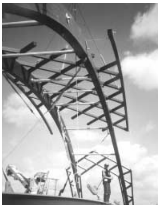
◀ Pose des panneaux de résille bois et des portiques bas métalliques.
