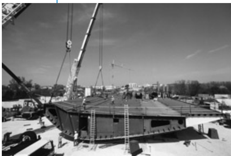
▼ Montage des tronçons sur site.
