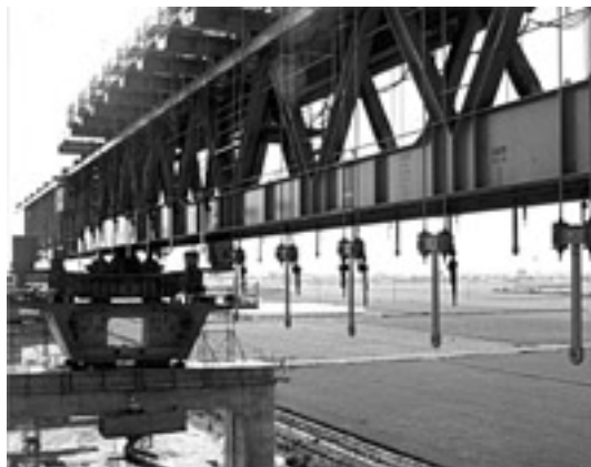
◀ Détail des systèmes de levage du cintre autolanceur.
