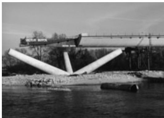
► L'avant-bec passe au-dessus des branches d'un tripode.
