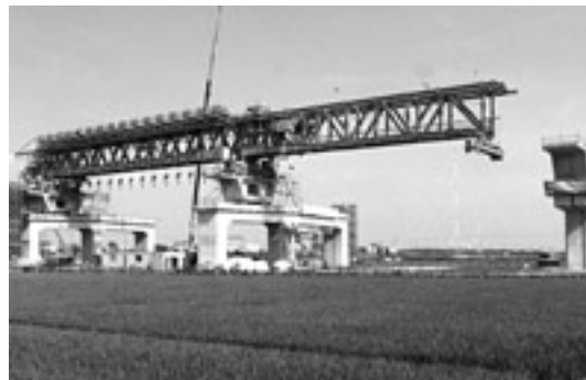
◀ Cintre autolanceur pour la construction des ponts avec voussoirs préfabriqués.
