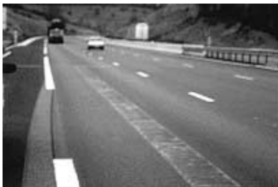
Illustration d'une position 4 : joint à revêtement amélioré longitudinal situé en dehors des bandes de roulement
