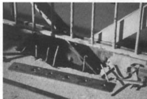
Les diagonales corrodées ont été renforcées par des plats boulonnés. Des fenêtres ont été ménagées. (Des boîtes métalliques soudées éviteront à l'avenir le contact béton-eau-acier)
