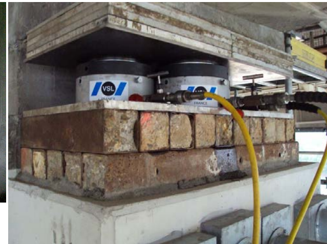
Suivi vérinage et changement des appareils d'appui
