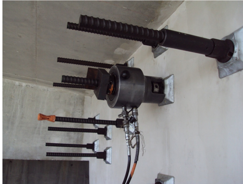
Contrôle mise en tension des barres de clouage
