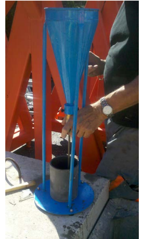
Contrôle de l'injection de protection des barres de clouage
