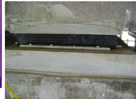
Suivi vérinage et changement des appareils d'appui
