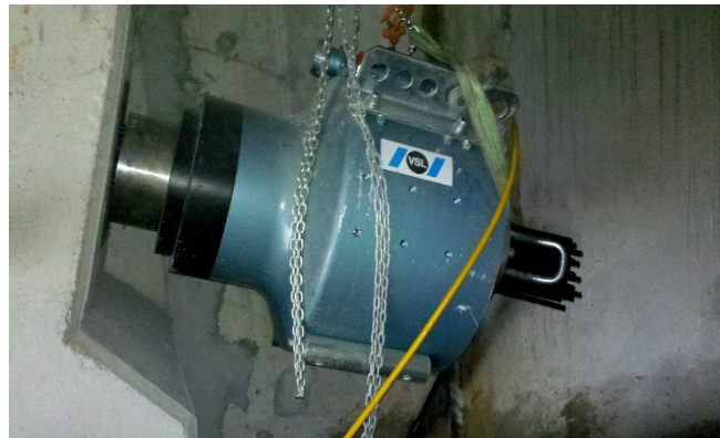
Contrôle mise en tension câbles de précontrainte
