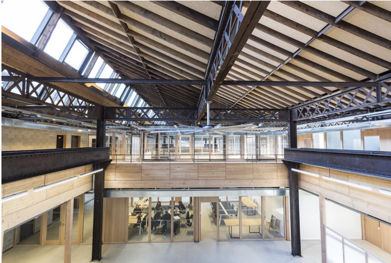
H7 – Halle GIRARD rénovée – VURPAS architectes – AIA Ingénierie
