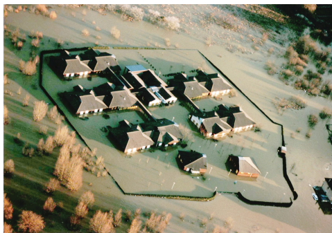
Crue de janvier 1995 (© DREAL Grand Est)
