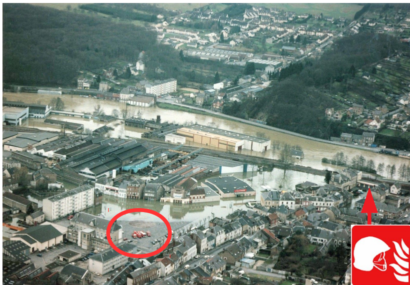
Crue de janvier 1995 (© DREAL Grand Est)
