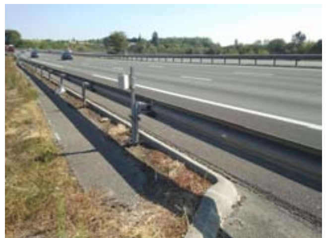
Poste 5 en section courante
