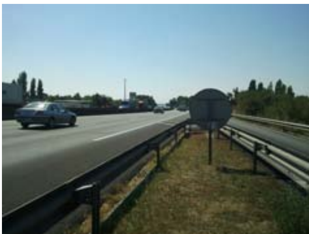
Poste 3 Insertion de l'aire de service
