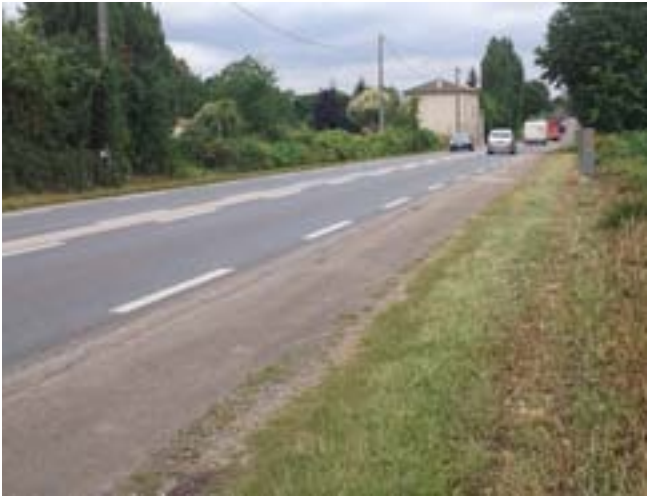
Poste 3 – Etat 0 - l'ETF contrôle le sens opposé
