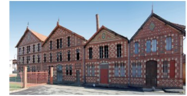
Les façades emblématiques des anciennes briqueteries Oustou constituent un ensemble remarquable du patrimoine industriel, aujourd'hui en friche. Tuiles et briques ouvrières, terres de vireges.
