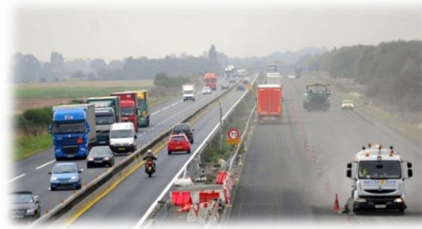
Organisation des travaux
