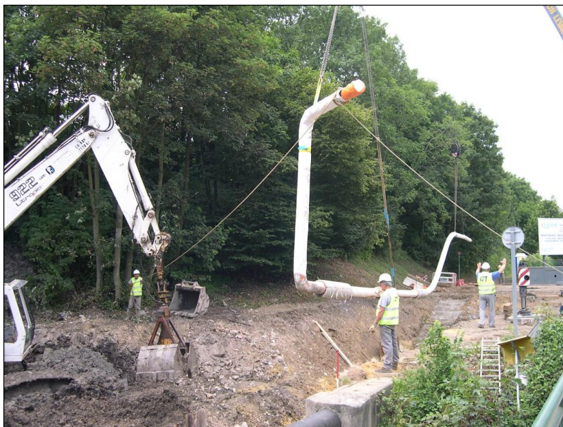
Illustration d'une baïonnette en cours de pose
