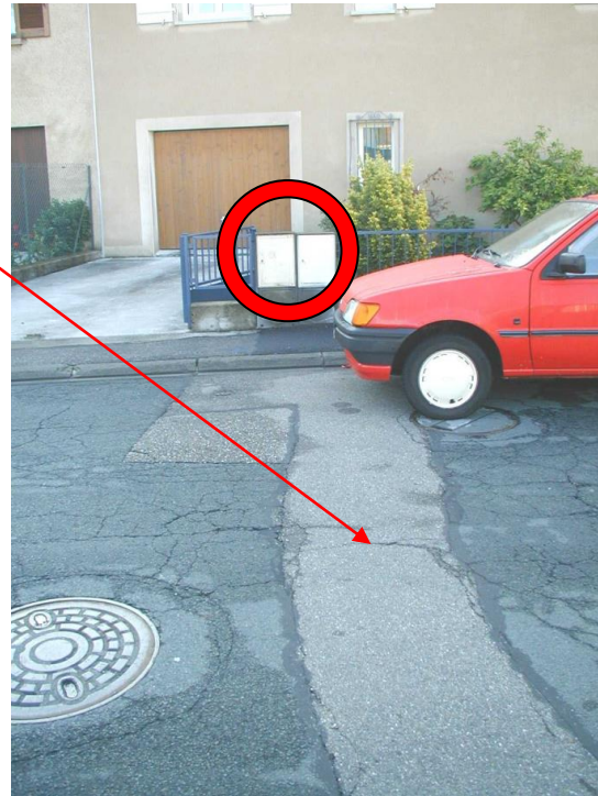
Autre indice permettant d'établir le tracé de l'ouvrage
