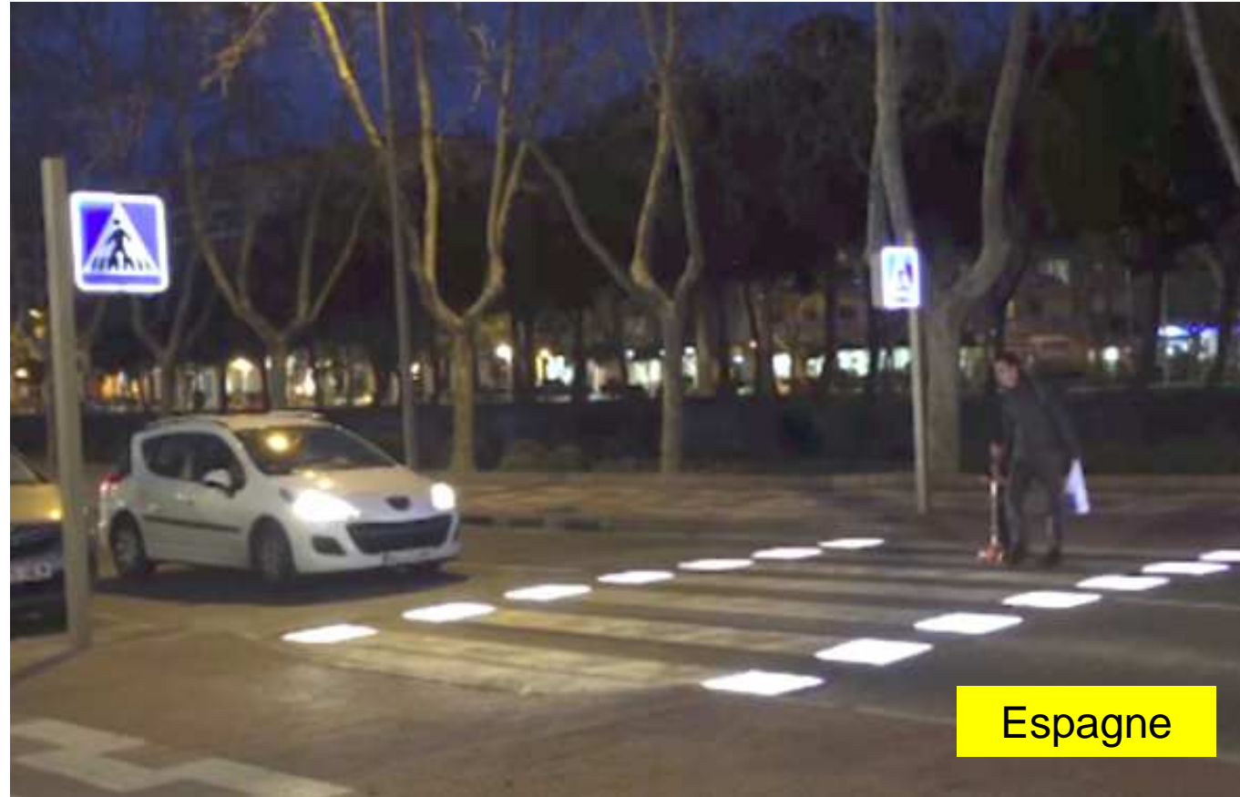
Dalles lumineuses dans le prolongement des passages piétons
