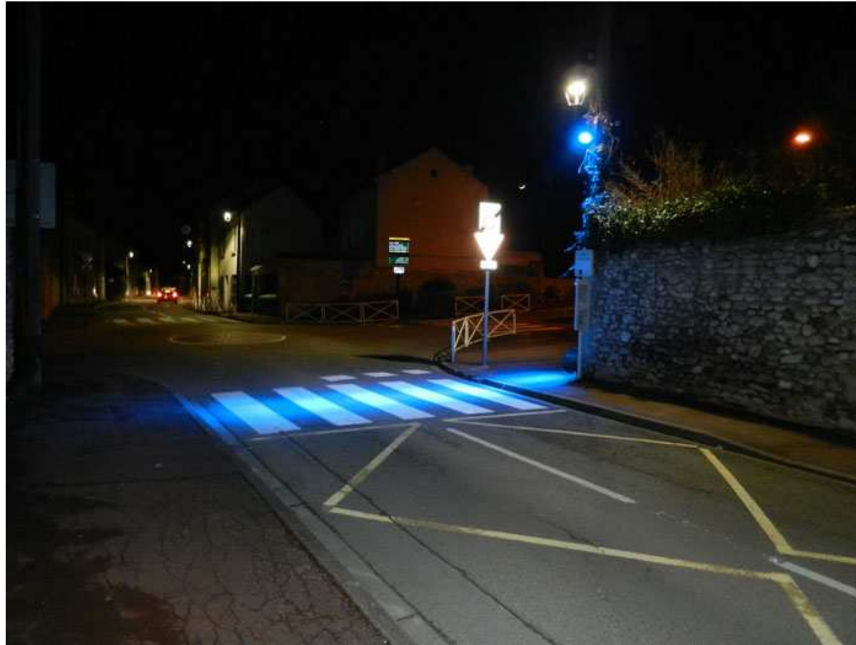
Eclairage des passages piétons
