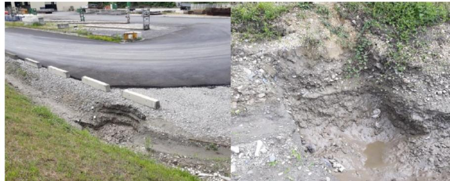
Figure 1 : Exemples de dommages sur digues, dus à l'homme, suite à travaux à proximité de l'ouvrage, sur pied de digue côté terre
