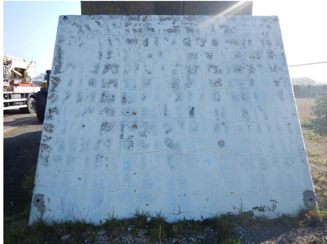
Socle – Pile N5 – face Ouest
