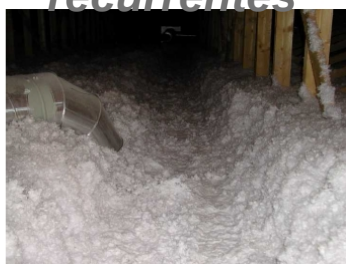
Absence d'isolant dans combles
