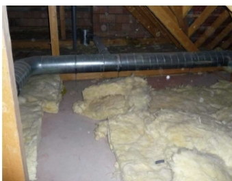
Absence d'isolant dans combles
