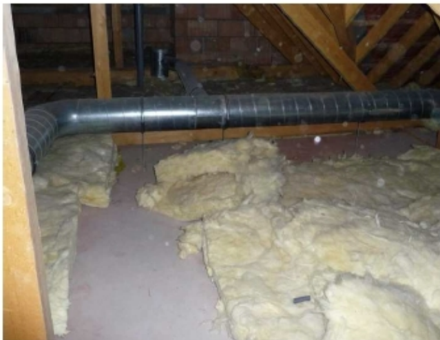
Absence d'isolant dans combles
