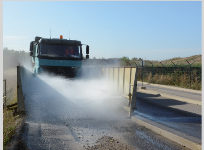
Nettoyage des pneus des véhicules avant la sortie de l'ISDI (© photo : UNED).
