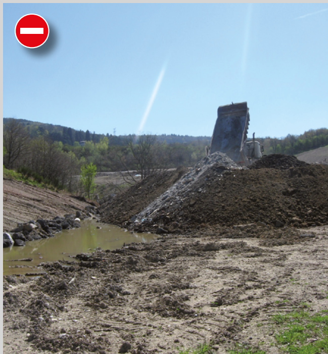
Mélange des bennes de déchets inertes sur la zone de contrôle (© photo : Cerema).
