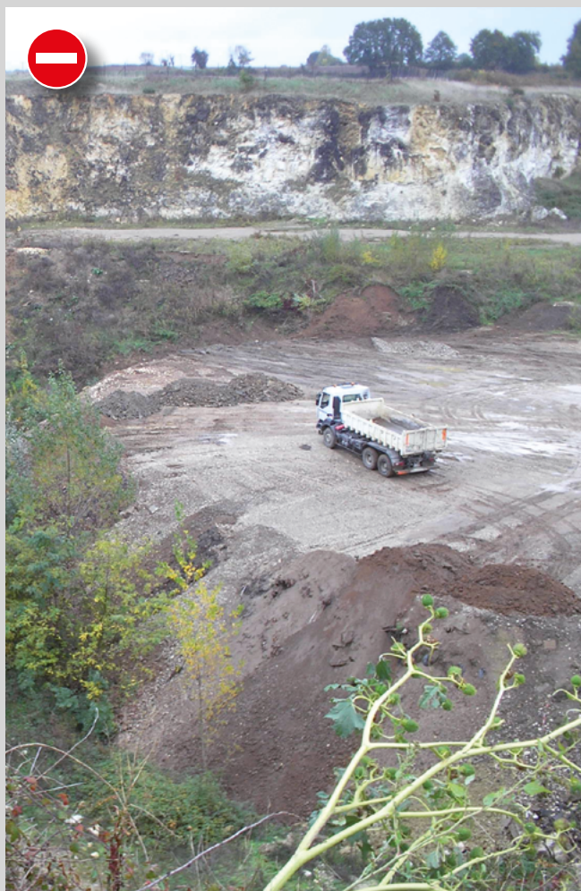
Pas de signalisation ni d'affichage de la zone de contrôle des déchets inertes (© photo : Cerema).
