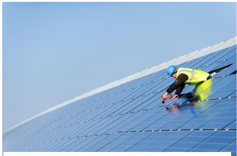
Pose de panneaux photovoltaïques dans un parc solaire—Arnaud Bouissou
