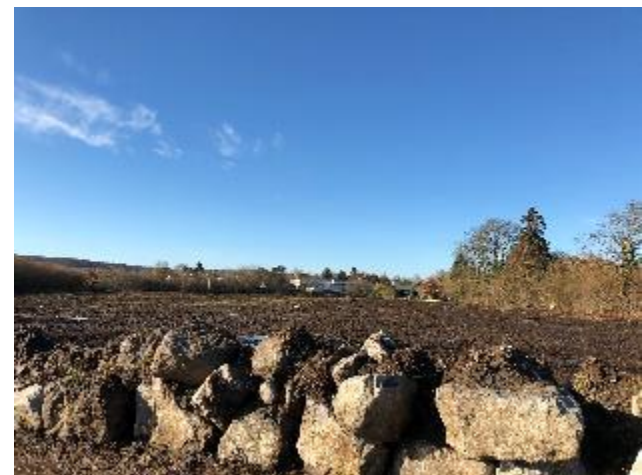
Trosly-Breuil : décapage pour restaurer des milieux ouverts, création de mares
