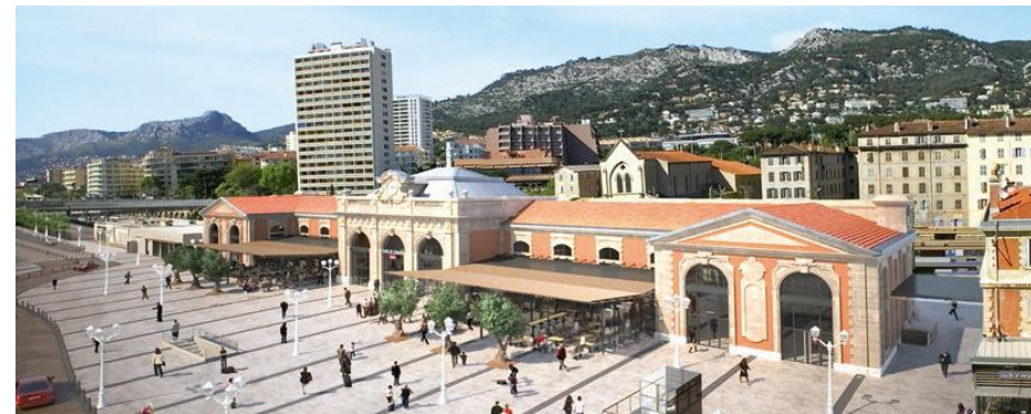
Pôle d'échanges gare de Toulon environ 26 M€
