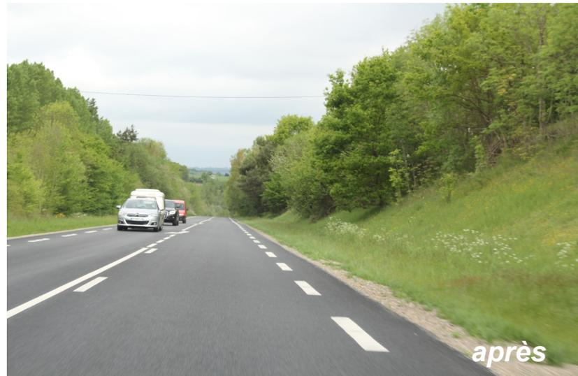
**Section bidirectionnelle** : réduction des largeurs de voie au profit d'une bande dérasée de droite avec alertes audio-tactiles
