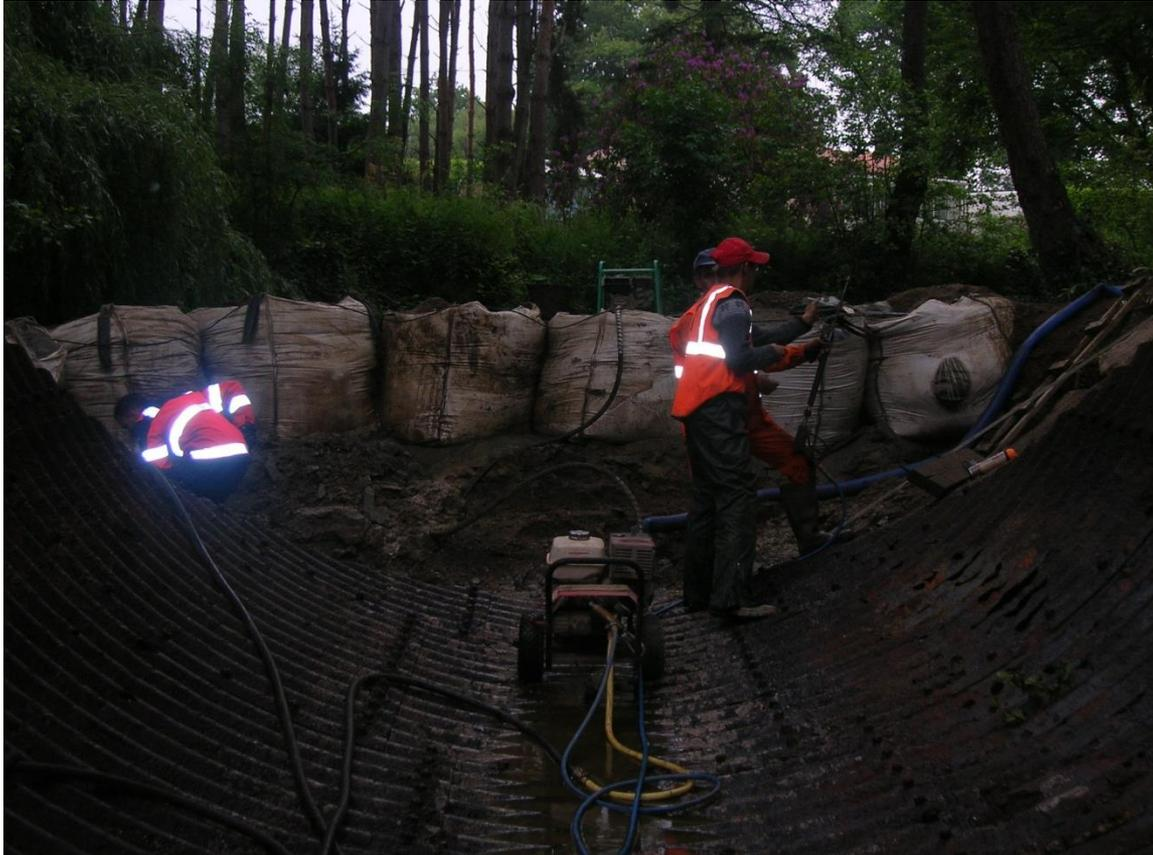
➤ **Mise en place du treillis soudé et des coffrages**
