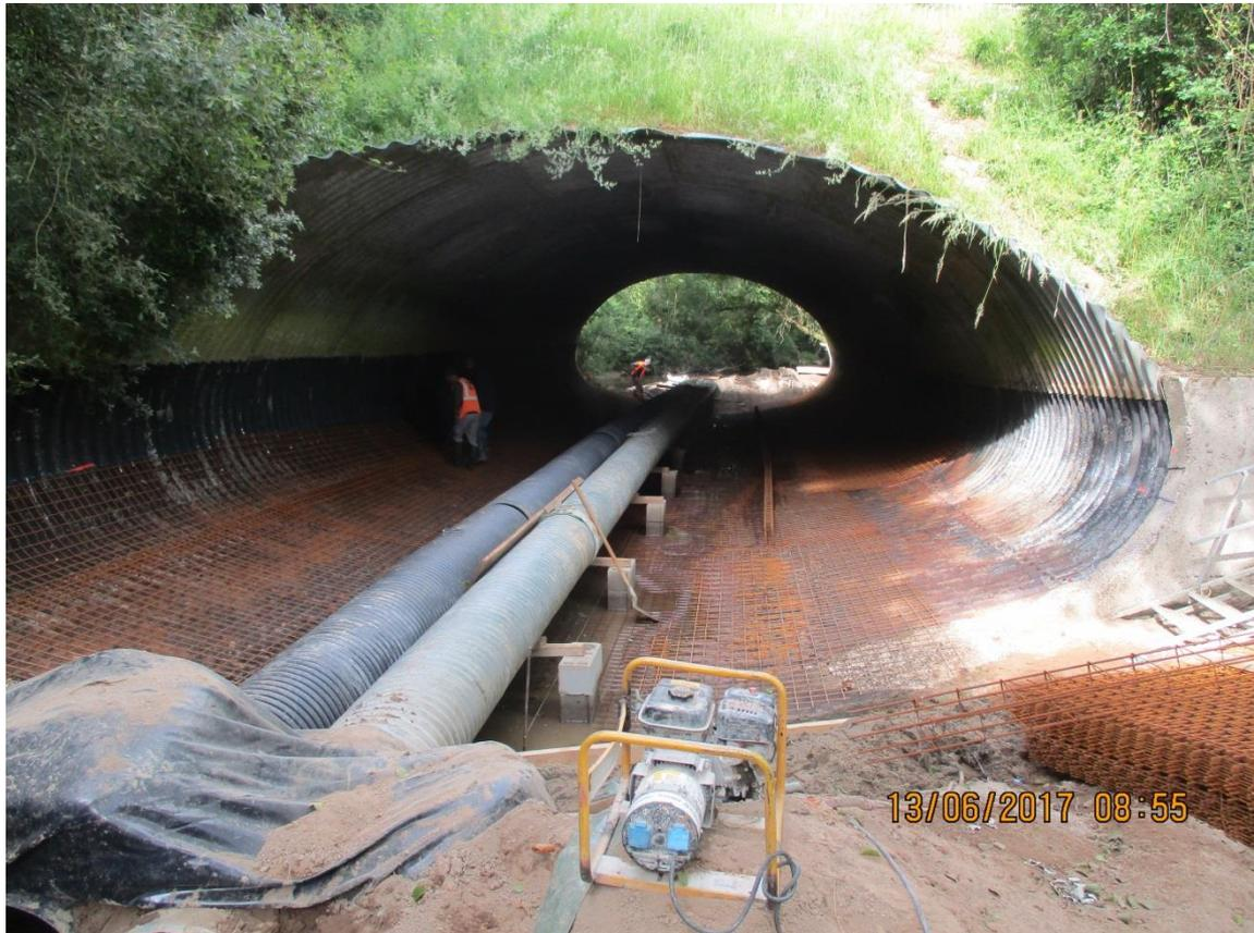
➤ **Mise en place du treillis soudé**
