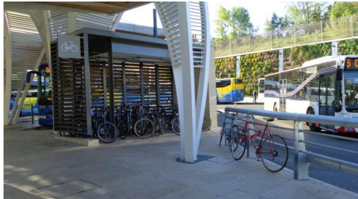
Pôle d'échanges à Aix-en-Provence - Crédit: Cerema
