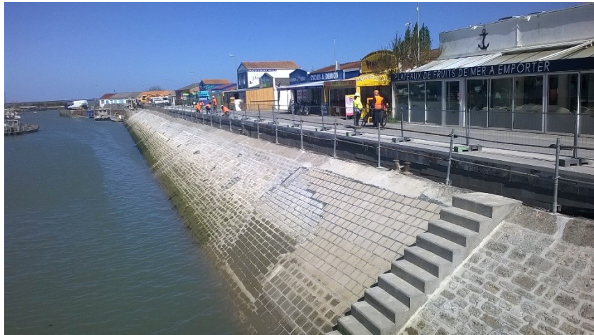
Digue de St Trojan (17)
