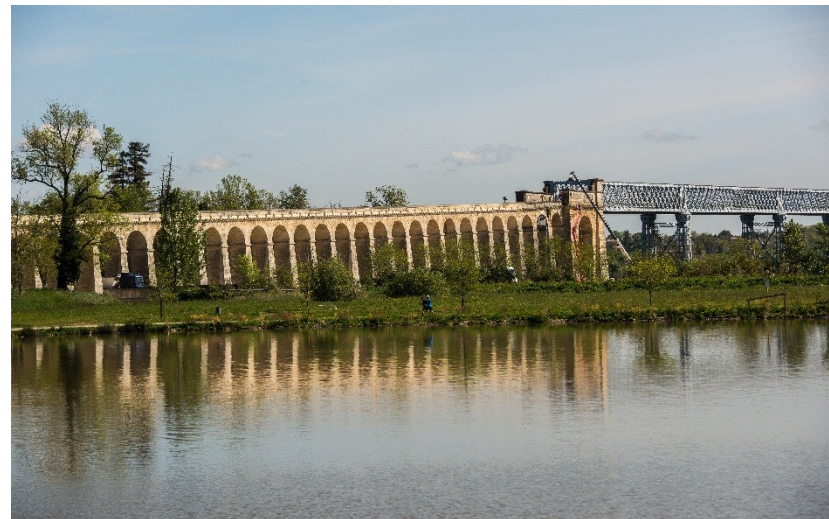
Pont de St André de Cubzac (33)
