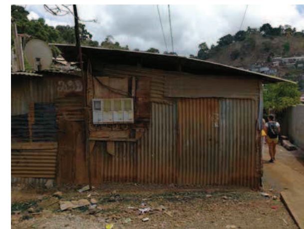
CONSTRUCTION DIRECTEMENT SUR TERRAIN PLAT (EN PARTIE BASSE DU SITE)
