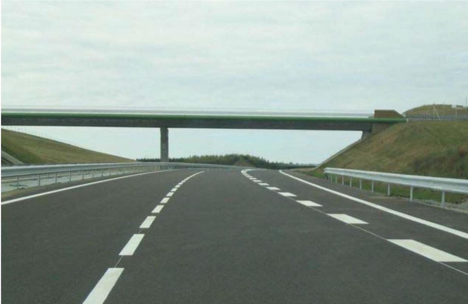
**Masque créé par le profil en long (risque de heurt d'obstacle sur chaussée ou de queue de bouchon)**
