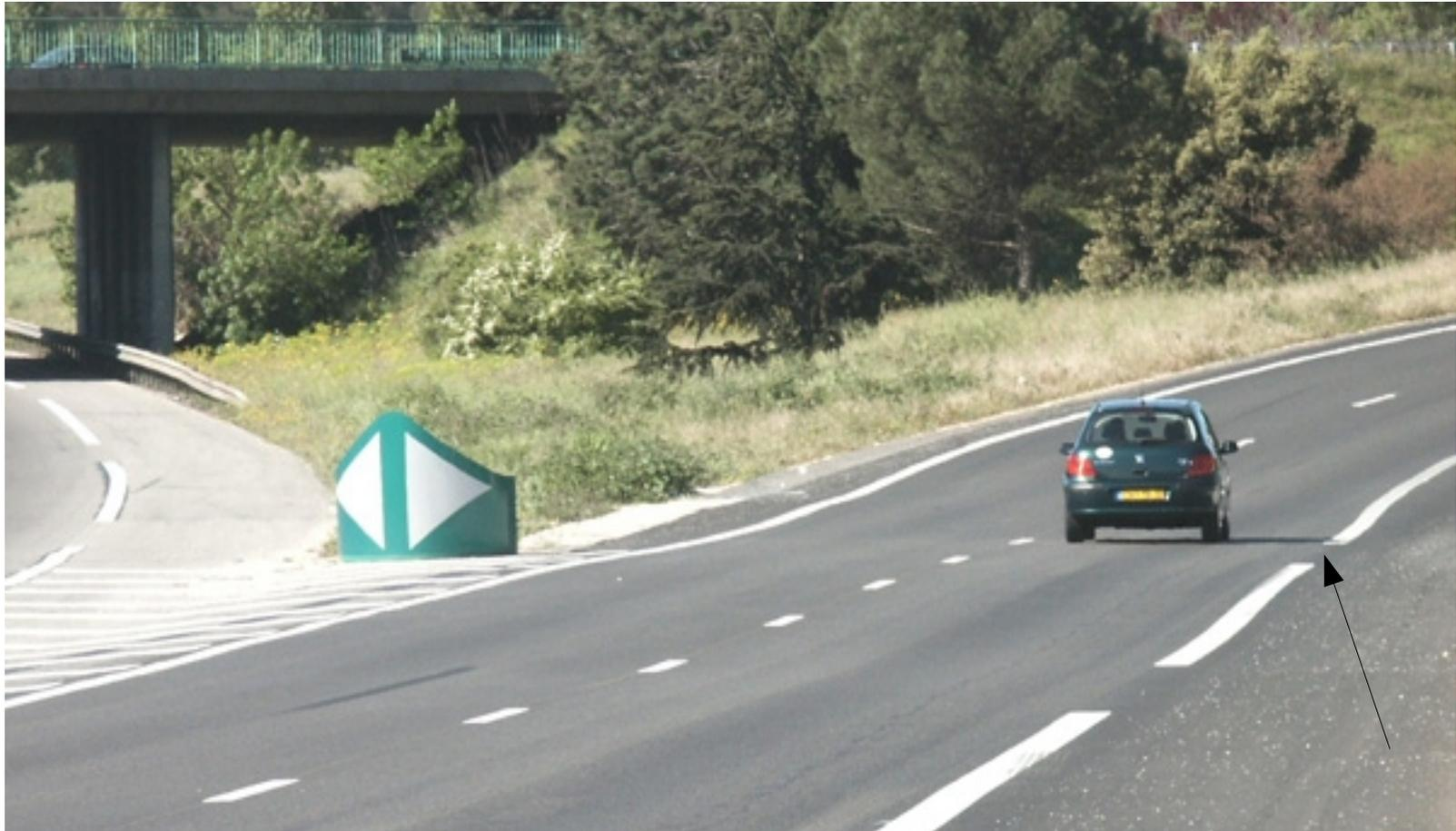
**Flache en section courante (décompression, risque d'accumulation d'eau)**
