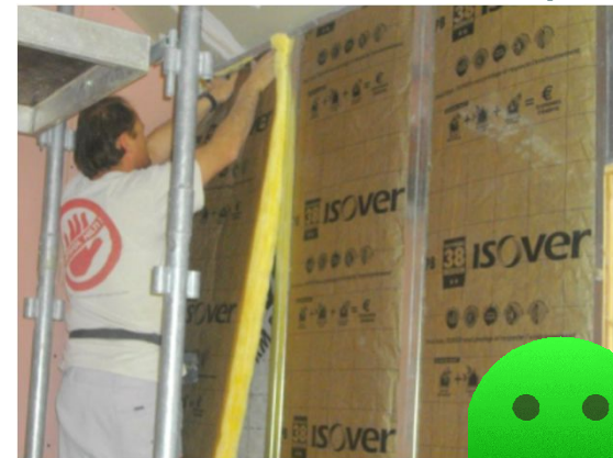
Pose d'une isolation croisée sur une crèche en Rhône-Alpes
