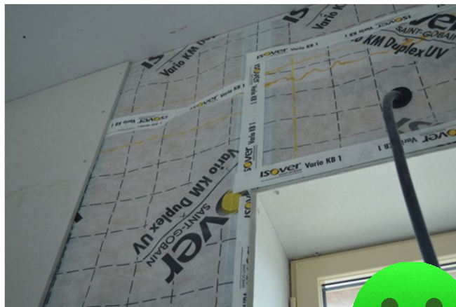
Traitement des retours de pare-vapeur avec le plafond et traitement des percements
