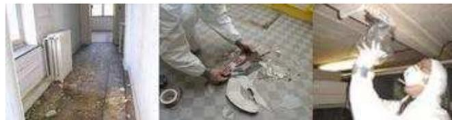
Le pôle QSB et le groupe Air et Bruit interviennent à Hellemmes dans une école dans le cadre de plaintes suite à des mauvaises odeurs survenues après le changement de revêtement de sol. Les mesures (COV, aldéhydes, particules, température, humidité, CO2) sont actuellement en cours.
