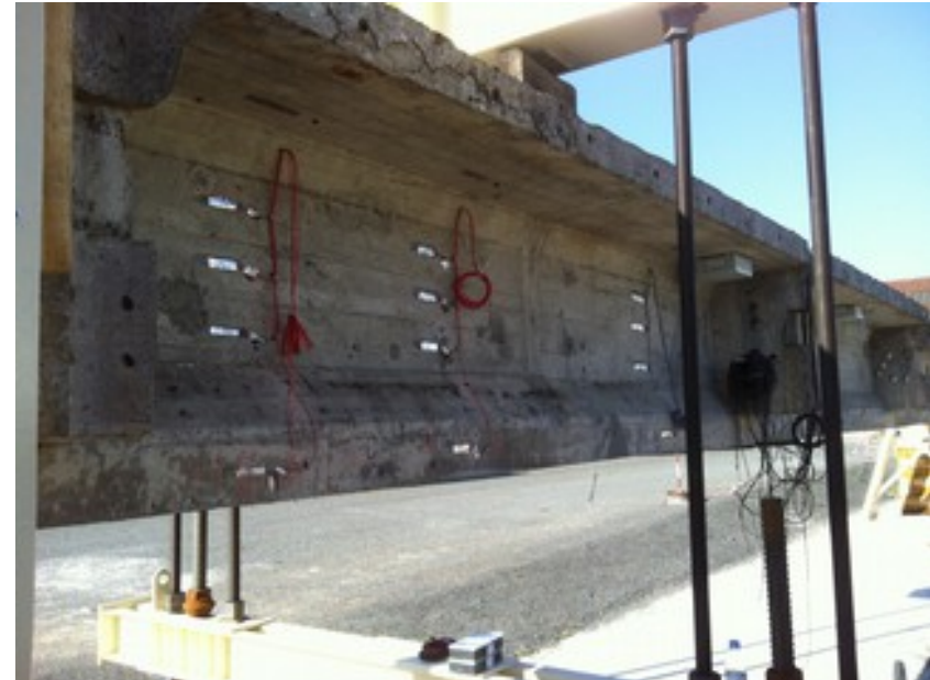
5 sections 12 jauges béton par section
