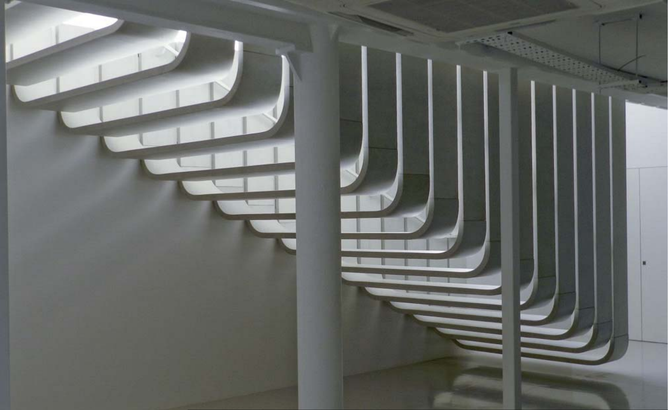
Show room Zaha Hadid / Londres / Il cantiere Prefabbricato
