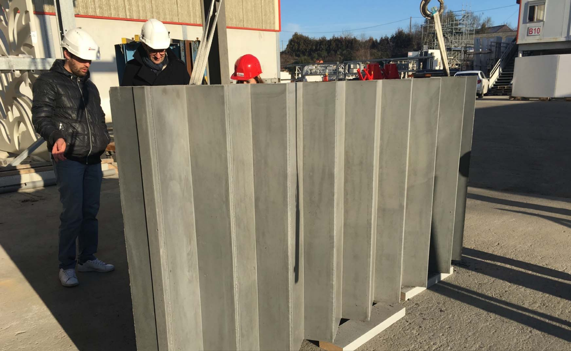
Escalier fondations les Galeries Lafayette, Paris / OMA Architectes / Jusselin Prefabriquant
