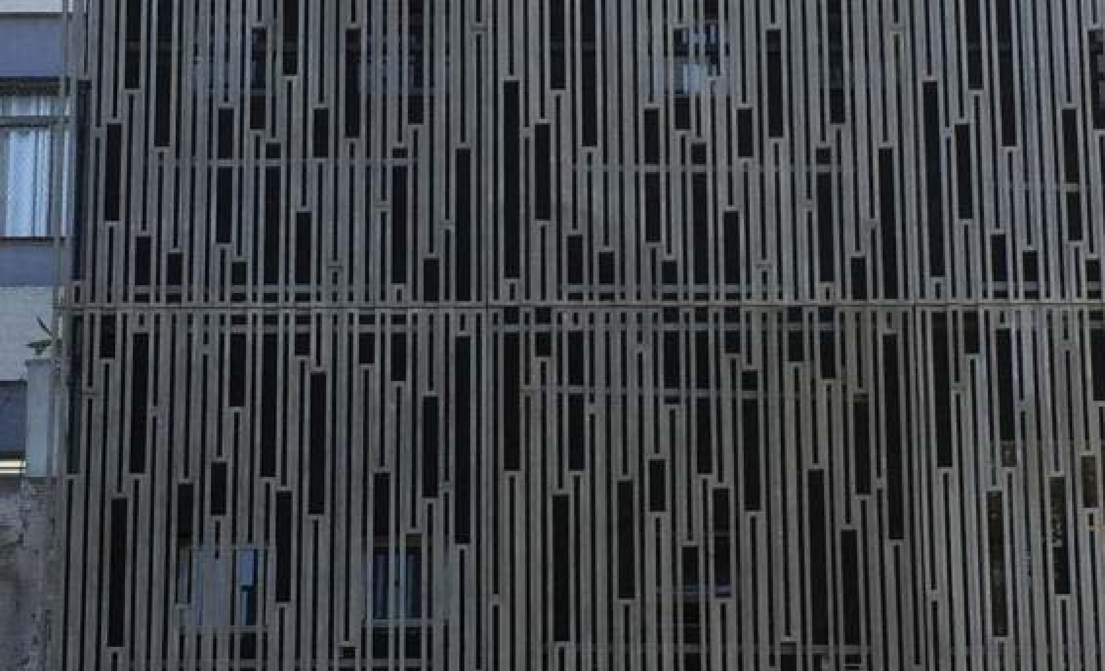
Panneaux à Sao Paulo, Bresil / stone Prefabriquant
