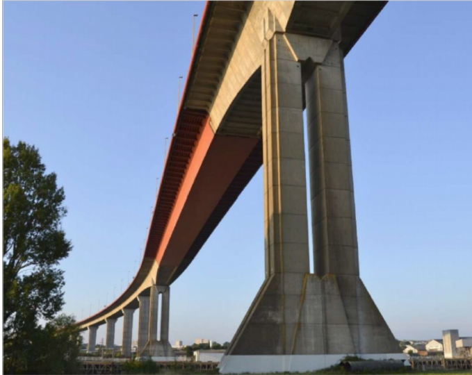
Cheviré Bridge ©Médiathèque Nantes-Saint-Nazaire
