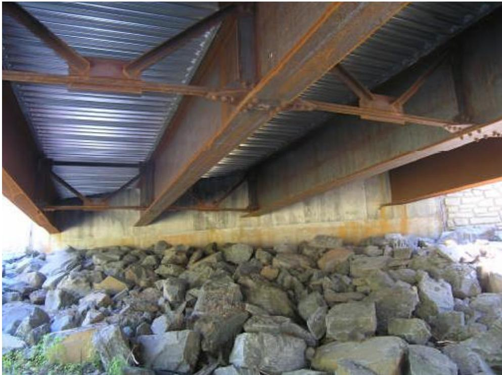
*Exemple de pont à poutres métalliques*
