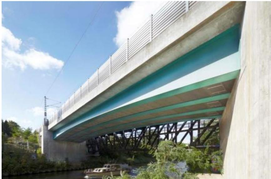
*Pont-rail sur le canal de Teltow à Berlin – Portée de 42m65 – Procédé breveté VFT® de SSF Ingenieure
