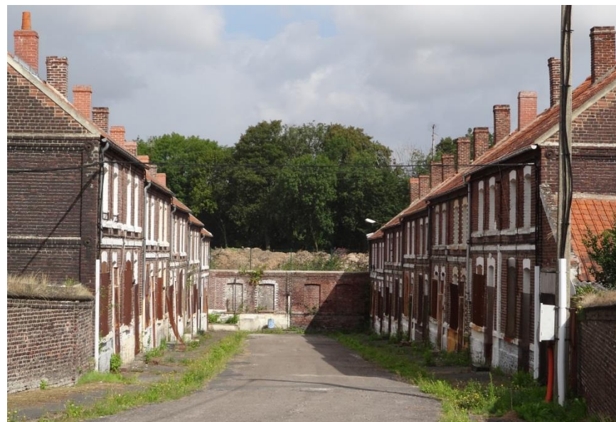
Corons dégradés et vacants, Bruay-la-Buissière
