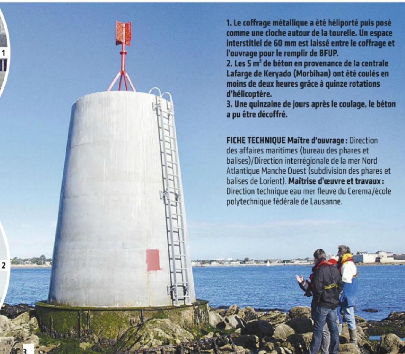
1. Le coffrage métallique a été hélicopté puis posé comme une cloche autour de la tourelle. Un espace interstitiel de 60 mm est laissé entre le coffrage et l'ouvrage pour le remplir de BFUP.
