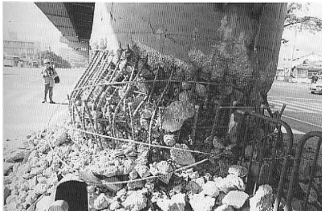
Recouvrements interdits dans les zones plastiques
