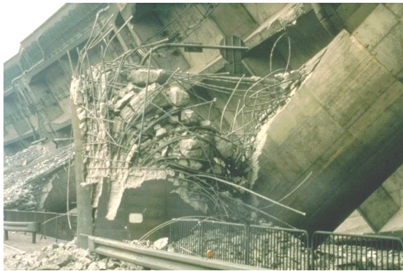
Densité importante d'armatures d'efforts tranchants
