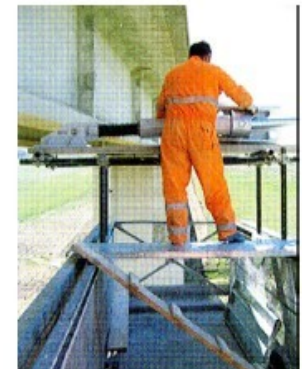
Installation d'amortisseurs
