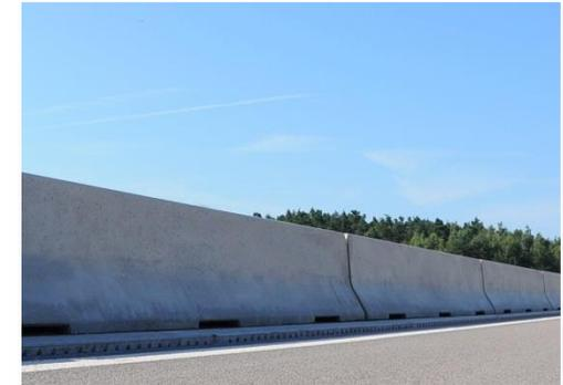
4- Les dispositifs de retenue routiers **en béton préfabriqué**
