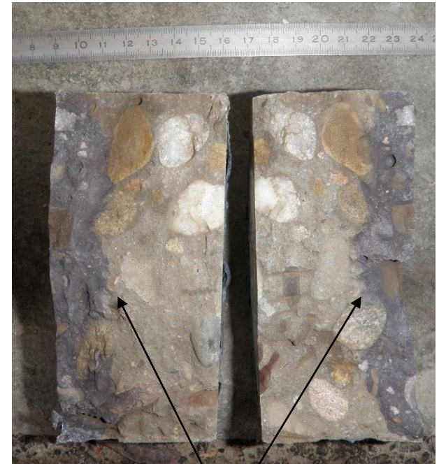
Front de pénétration des chlorures
