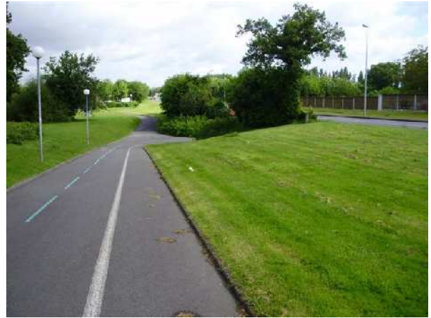
Rétablissement d'une traversée d'une piste cyclable
