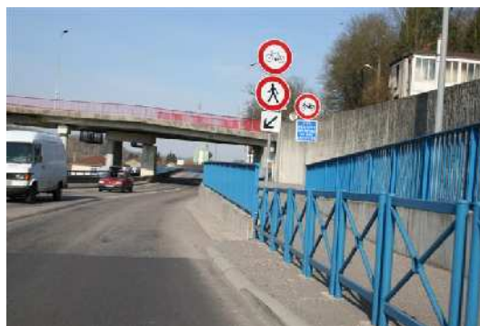
Cheminement réservé aux piétons et cyclistes
