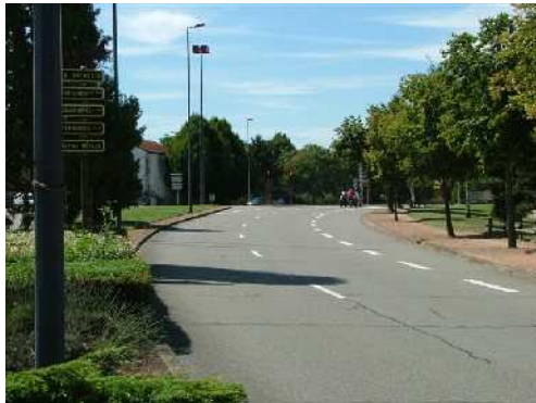
carrefour à feux sur la section Nord
