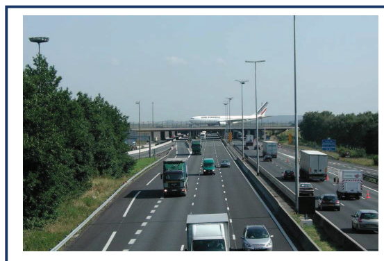
Autoroute A1 - Roissy
