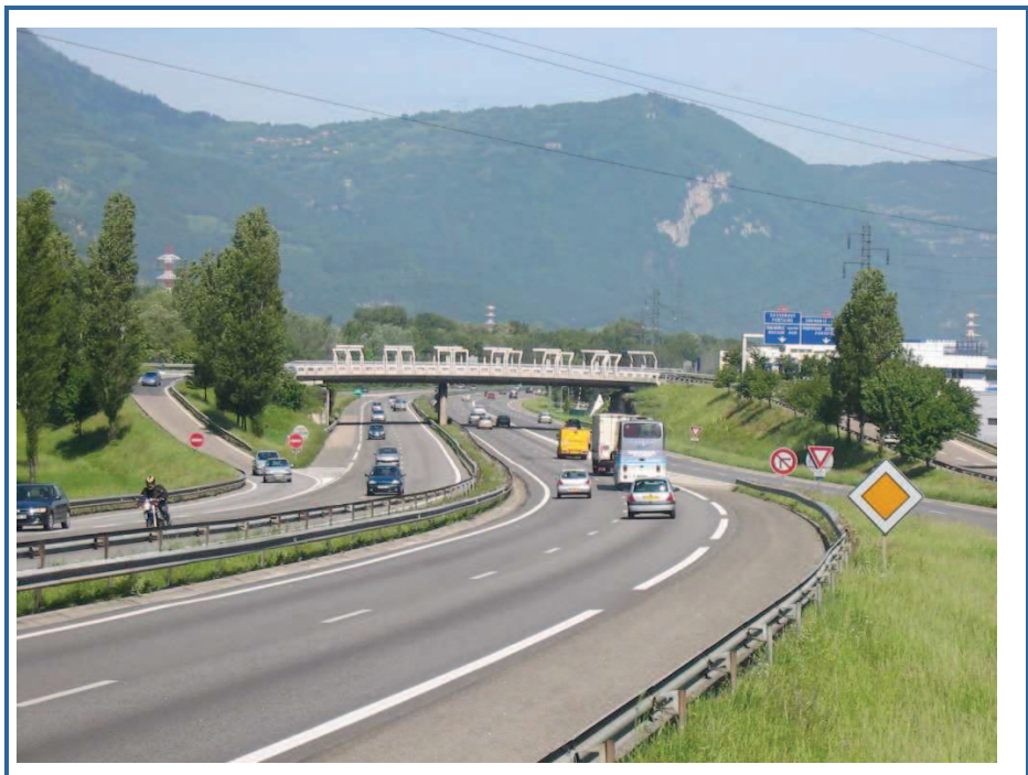
A 480 en périphérie de Grenoble
