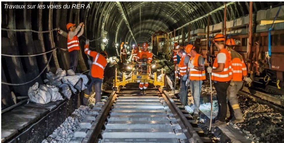
Travaux sur les voies du RER A
