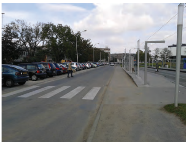
Illustration 11: Masque créé par le stationnement pour les traversées aux abords d'une station (Crédit photo : Cerema)
