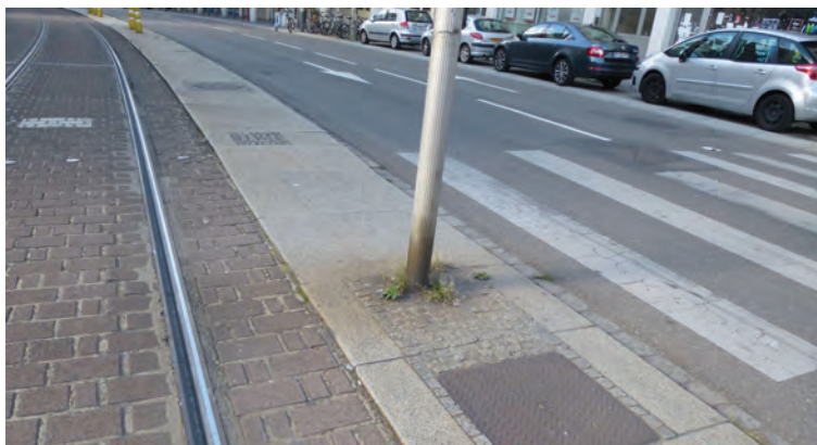
Illustration 7: Espace entre voies routières et plateforme tramway de petite taille (Crédit photo : Cerema)
