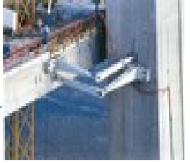
Amortisseurs élasto-plastiques équipant le pont Vasco de Gama (Portugal)
