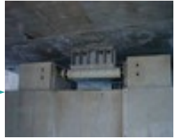
Amortisseurs élasto-plastiques équipant le pont Vasco de Gama (Portugal)
