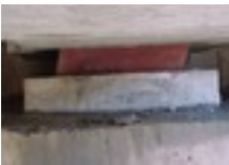
Appareils d'appui en élastomère fretté classiques...
