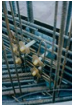
Photos 14-15 : Ferrailage de diffusion des efforts locaux au niveau des ancrages
