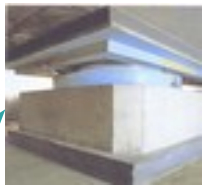
Appareils d'appui à pot classiques
