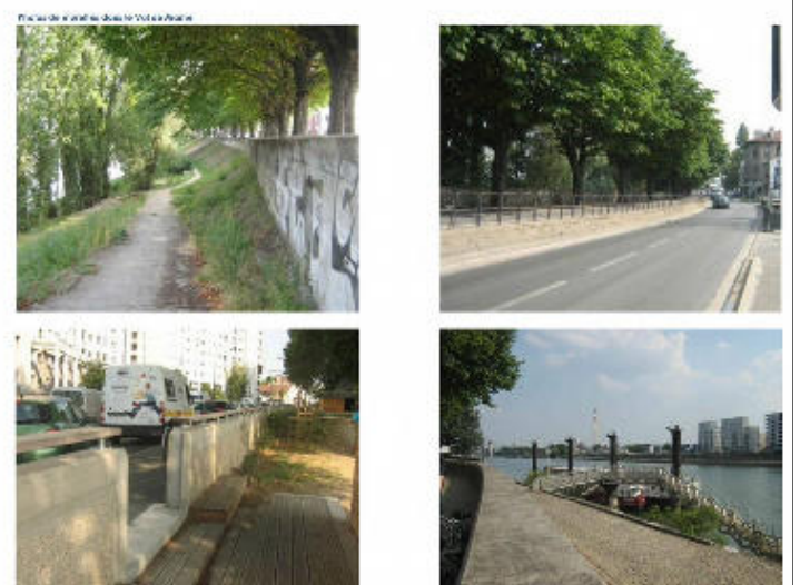
Les murettes anti-crues au droit du site
