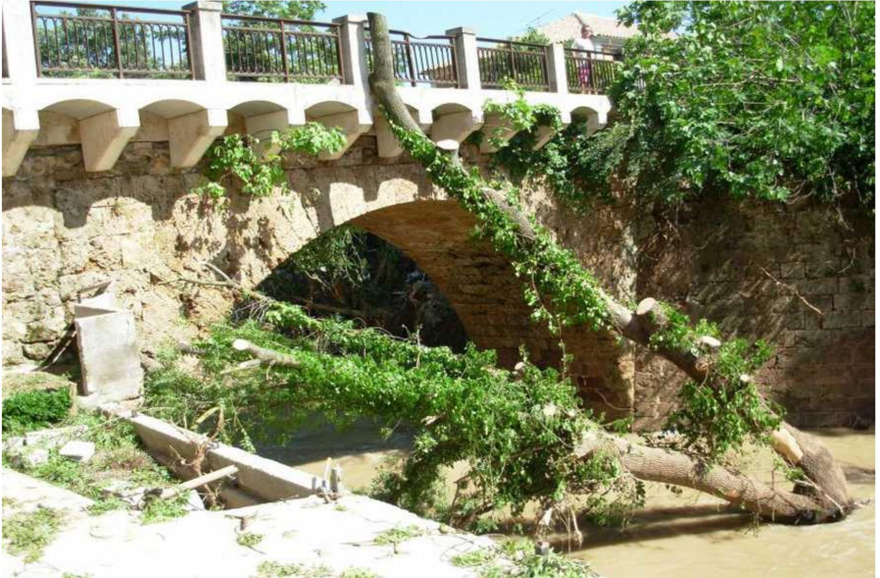
Voûte en maçonnerie ( Tuf) de 12,00 m d'ouverture
