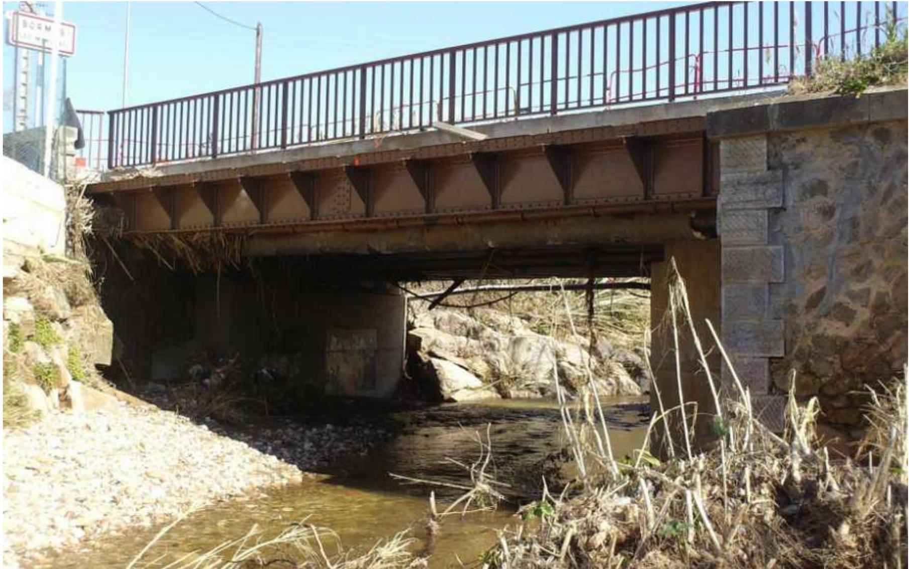
Pont constitué d'un tablier métallique à poutres treillis élargi par un tablier à poutres précontraintes (Ouverture droite 10,00 m – largeur 13,60 m- tirant d'air 3,40 m)
