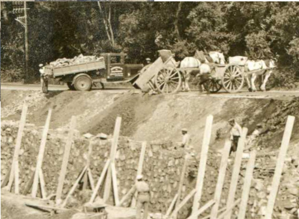
Mur en maçonnerie d'une hauteur de 4,50 m
