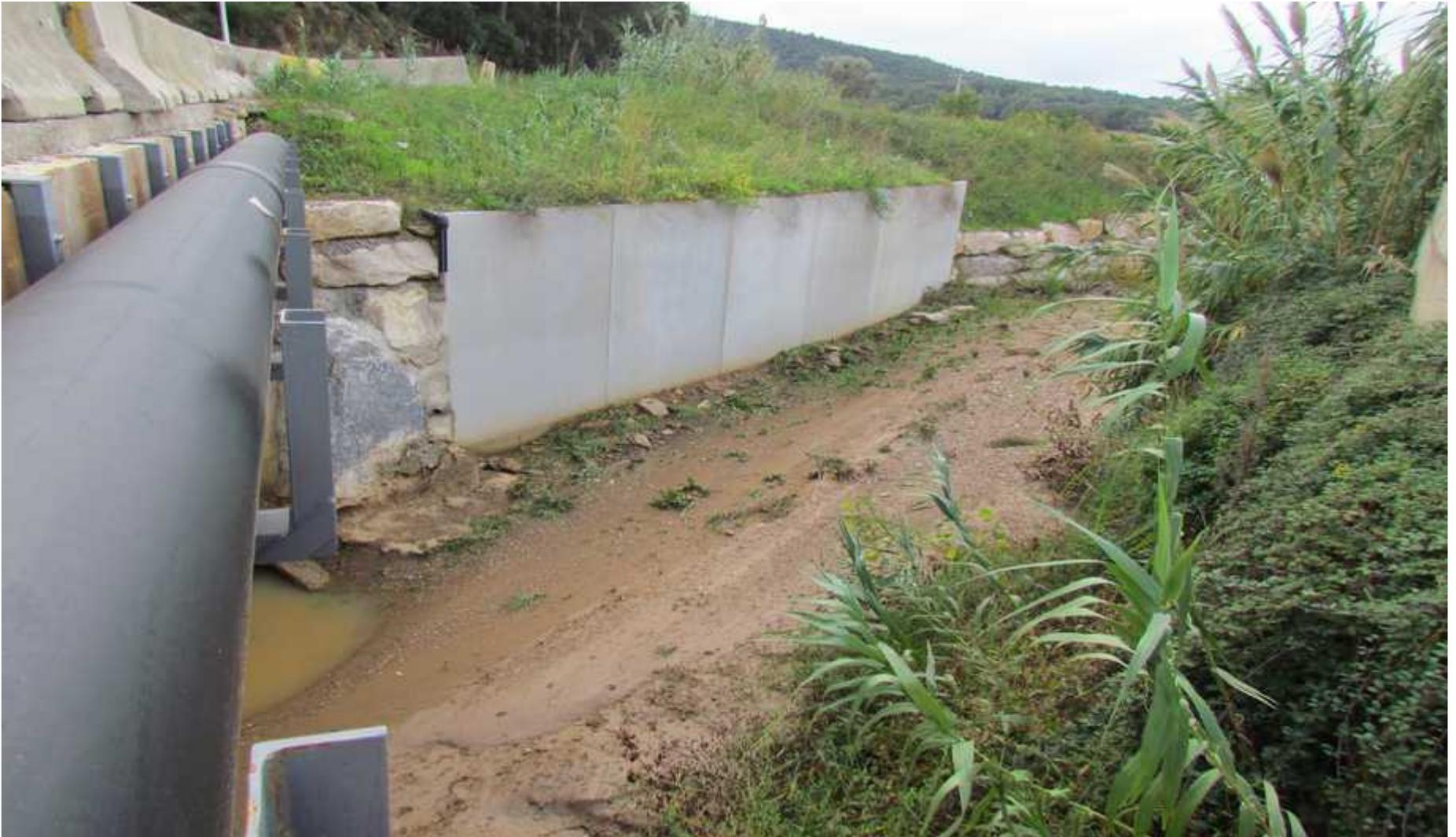
Rétablissement des différents réseaux et **aménagement provisoire** de l'entonnement amont rive droite dans l'attente de la **construction d'un nouveau pont** pour augmenter la capacité hydraulique et améliorer l'écoulement du cours d'eau.
